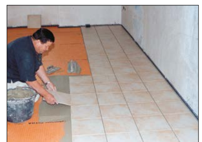
12 Verlegung des Fliesenbelags auf DITRA in Dünnbettmörtel.
