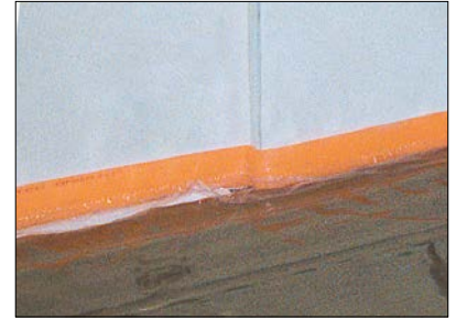
3 Einbau des Randstreifens BRS 810 oder BRSK 810 bei erdfeuchtem Estrich. Bei Fliebestrich sind die Randstreifen BRS 808 KF oder BRS 808 KSF mit Klebefuß zu verwenden.
