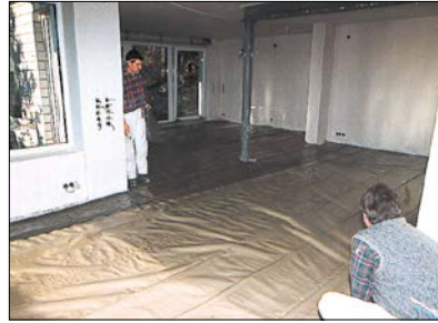
2 Einbau einer Abdecklage bei Verwendung von Fliebestrichen.
