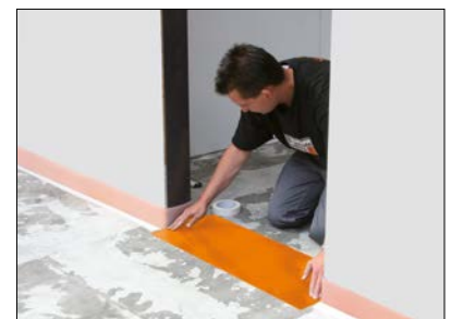
6 Türbereich – Ausgleichsplatte EN FG (glatte Folienplatte) einpassen.
