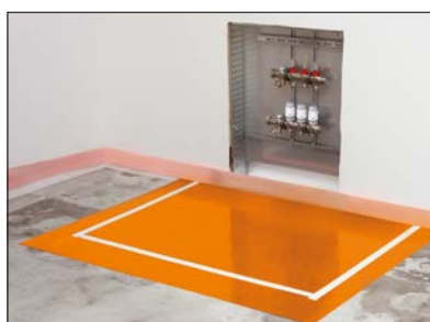
5 Verteilerbereich – beigefügte Doppelklebebänder aufbringen.
