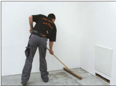
1 Reinigen des ausreichend tragfähigen und ebenflächigen Untergrundes.
