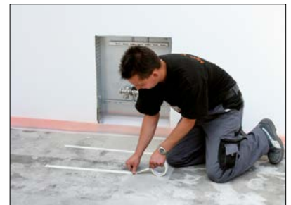
3 Verteilerbereich – beiliegendes Doppelklebeband auf dem Boden anbringen.
