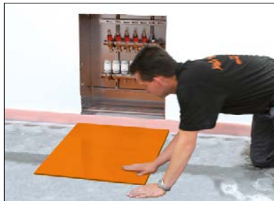
3 Verteilerbereich – Ausgleichsplatte EN FGTS (glatte Folienplatte) einpassen.
