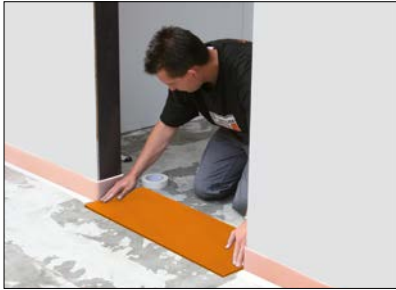
5 Türbereich – Ausgleichsplatte EN FGTS (glatte Folienplatte mit 5 mm Trischalldämmung) einpassen.
